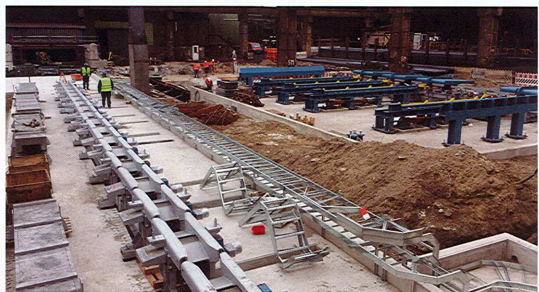
Die letzte Phase beim Bau des neuen Hubbalkenofens
