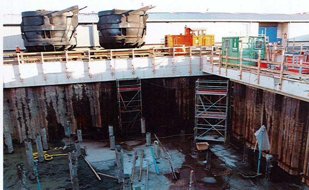
Logistische Meisterleistung: In gut zehn Stunden lieferten 120 LKW ihre Betonladungen für das neue Fundament.
