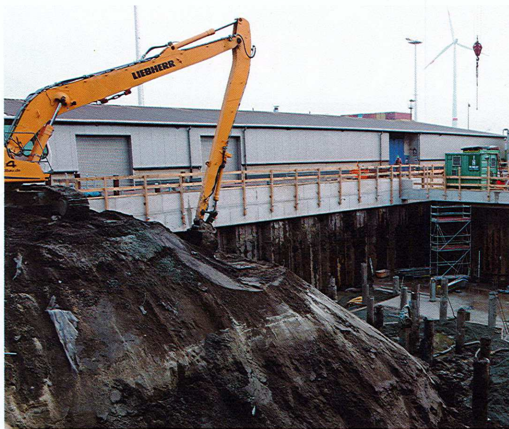
Der erste Schritt auf dem Weg zu einem neuen Hubbalkenofen war der Aushub der Baugrube.
