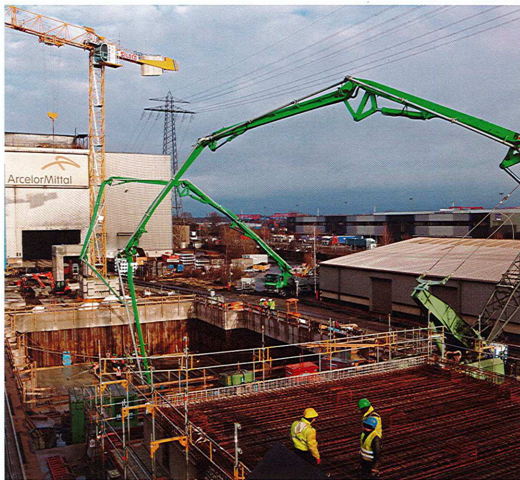
Die Knüppel sollten länger werden – dafür musste der neue Wiedererwärmungsofen gebaut werden.
